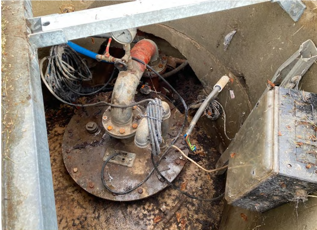
Tiefbrunnen mit elektrischer Ansteuerung der Pumpe
